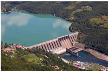
(1) Pembangkit Listrik Tenaga Air
