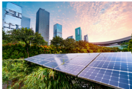
(4) Pembangkit Listrik Tenaga Surya
