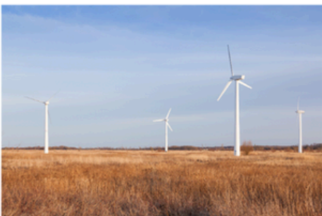
(2) Pembangkit Listrik Tenaga Angin
