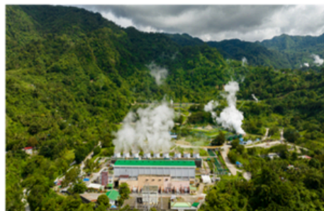
(3) Pembangkit Listrik Tenaga Panas Bumi
